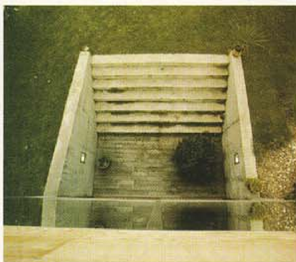
Le sous-sol aménagé en bureau est inondé de lumière naturelle grâce au principe de la cour anglaise.
